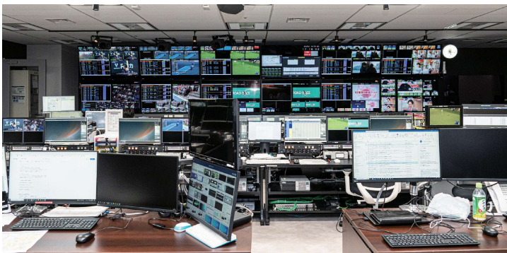
▲ テレビマスター監視室にある監視用コンソールのひとつ。KVM over IP コンソールステーション (KA8288) を設置
