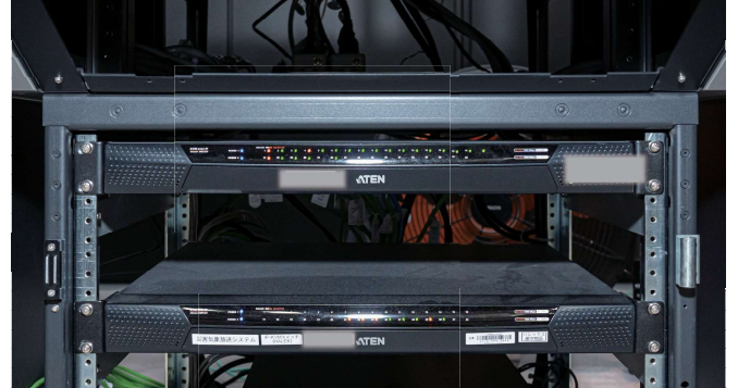
▲ テレビマスター監視室にあるマルチポート IP-KVM スイッチ (KN8132V)
