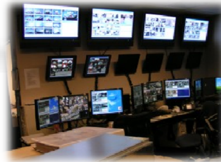
中央安控機房
